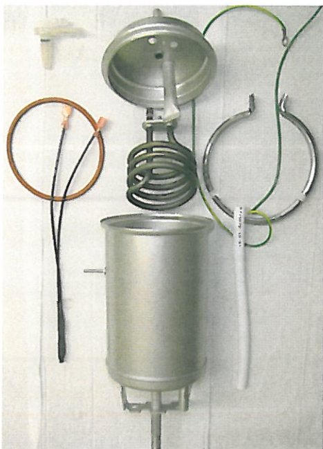
Razstavljen grelec za toplo vodo
